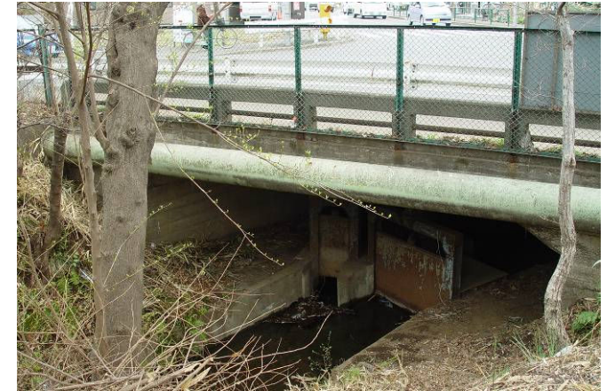
小川橋北側・新堀用水橋下に小川用水分岐水門が見える
