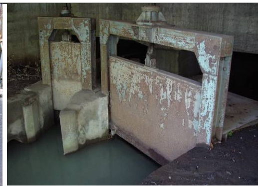
② 小川用水分岐水門 (左・小川用水 右・新堀用水) 小川橋上流側橋下。巻上機は1960年施工
