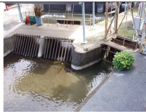
① 小平監視所内の新堀用水取水口 (左・上水本流芥止め 右側・新堀用水取水口)
