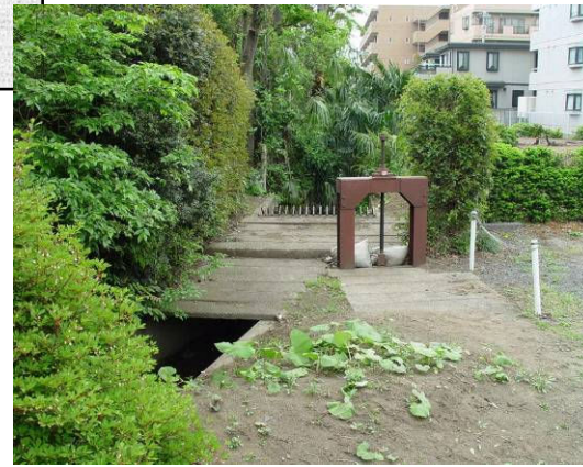
⑤ 喜平町分岐水門 (左・新堀用水 右・鈴木用水) 喜平町警察学校宿舍南側駐車場内。鈴木・大沼田用水は ここから暗渠となり団地東へ。巻上機は片側のみ設置さ れている(1973年施工)
