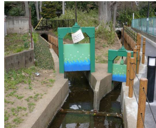
⑥ 回田町分岐水門 (左・大沼田 右・鈴木用水) 小平団地東交差点 巻上機は1973年施工
