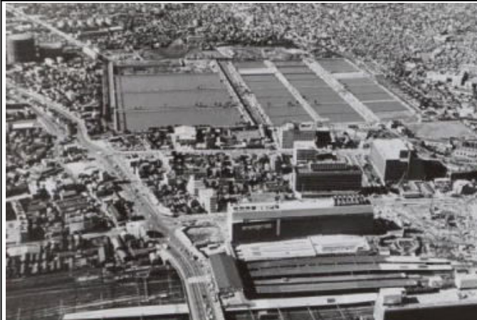
昭和30年頃の淀橋浄水場(手前は新宿駅)
