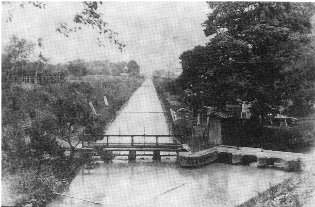
新水路(中央)分岐水門 (東京都水道歴史館)
