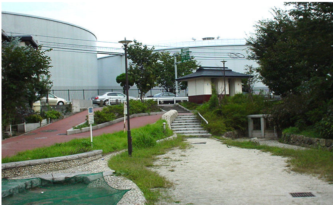
旧玉川上水路から見る和泉水圧調整所の大型貯水タンク
