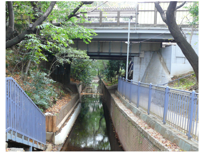
代田橋駅ホーム(上)と玉川上水
