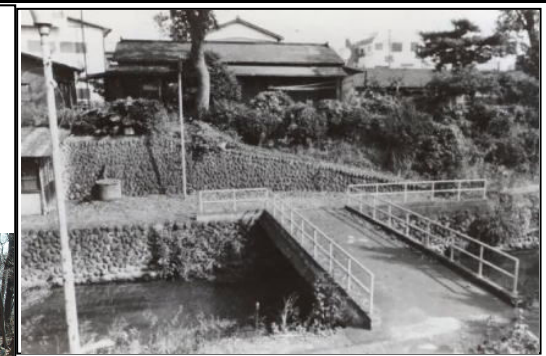
旧熊川水衛所・現どんぐり橋付近
