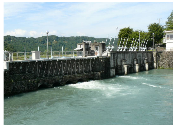
羽村取水堰・第一水門 (左側旧水門、右側新水門)
