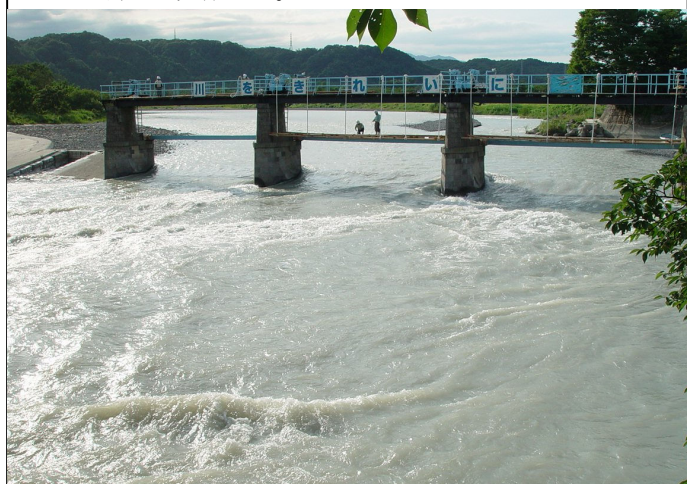
払われた投渡堰・仕付け(再構築作業)が始まる
