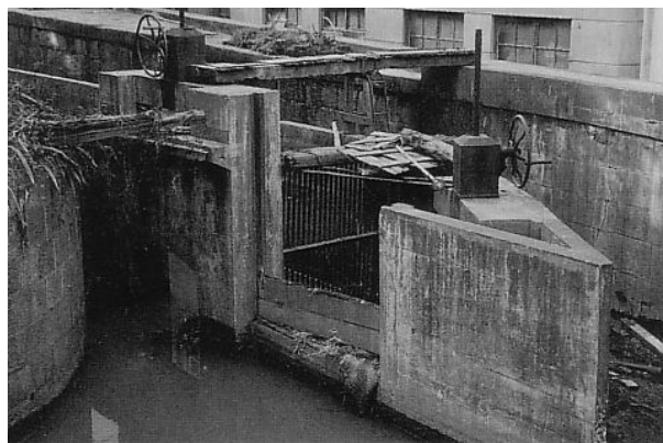
四谷大木戸・渋谷川への吐水門 都水道局「水道400年のあゆみ」から
