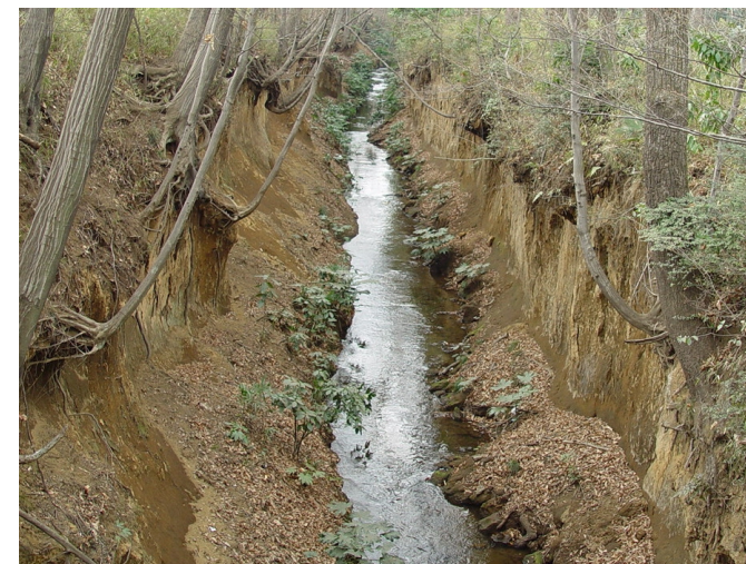
素掘りの南壁(左)と北壁(右)の違い 寺橋から上流方向
