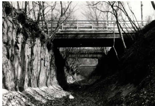
堀底から見る鷹の橋・西武線鉄橋・東鷹の橋(昭和60年頃)
