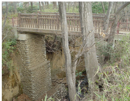
練り玉石積みみの寺橋の橋脚
