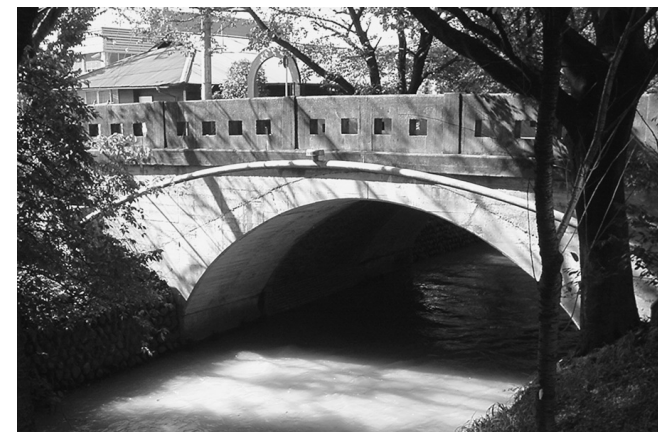
日光橋(福生市)の美しいアーチ型橋脚
