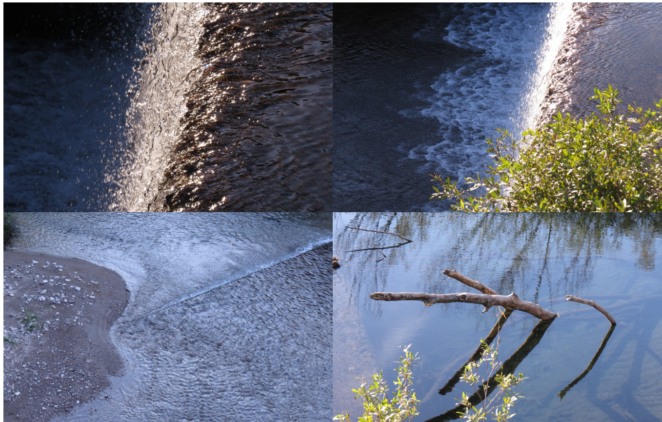
*岡山県真庭市上蒜山登山口付近・湯船川に設けられた堰堤（えんてい） 堰堤は、貯水・治水・砂防などの目的で、河川・渓谷を横断してつくられる堤防・ダム。
